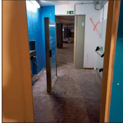
il collegamento con il vano scala
